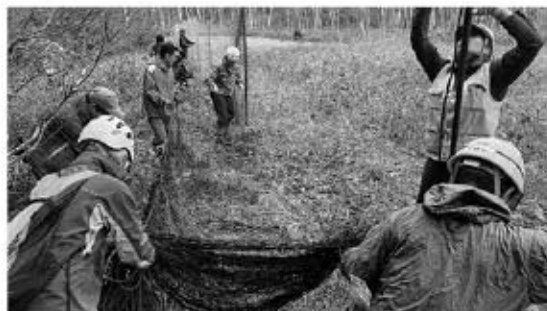
植生保護柵の設置作業（研究見本園）
