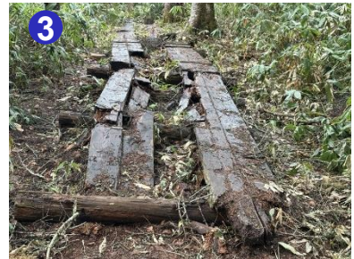
3 木道が破損している区間があります。足下に注意して進みましょう。
