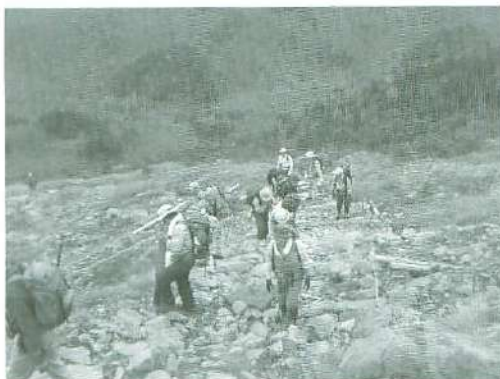
▲至仏山東面登山道踏み込み防止柵撤去作業 (実施日 H20.10.26)
