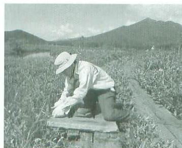
▲木道補修作業の様子
