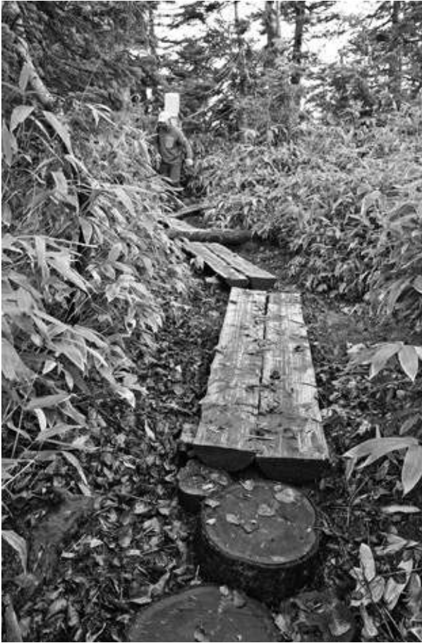
写真3. 倒木を活用した施工方法 (2022整備区間)
