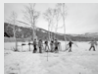
シカ柵（ニホンジカ侵入防止柵）設置作業
