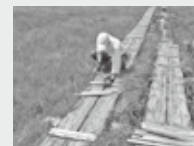
木道の栈木打ち作業
