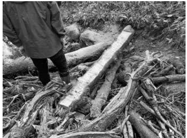
写真4. 大小様々な木端を敷き詰める
