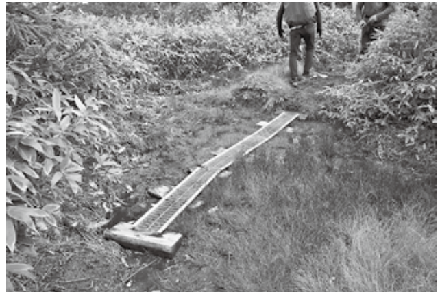
写真2. グレーチングを活用した歩道 (2022整備区間)
