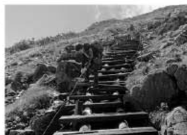
鉄杭撤去の様子
