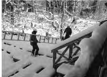
▲11/5の積雪の中、閉所作業の様子
