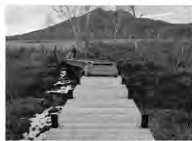
▲竜宮の沼尻川橋ではまだ工事が進められていました
