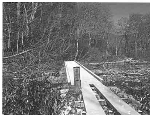
山の川上川橋
