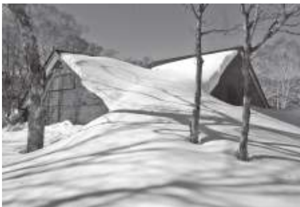
▼ 尾瀬山の鼻ビジターセンター（裏側から）
