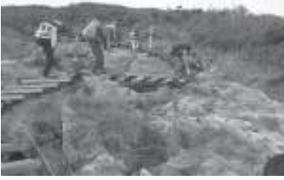
▲ 柵倒し作業中
