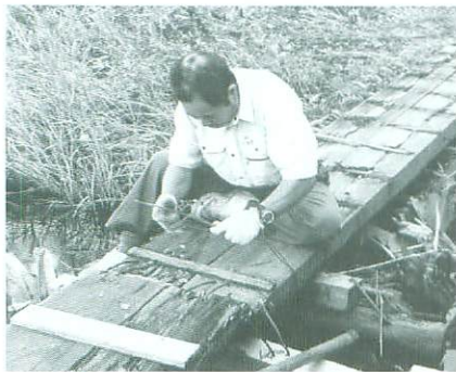
▲尾瀬ヶ原の木道補修を行う星野さん(平成11年)
