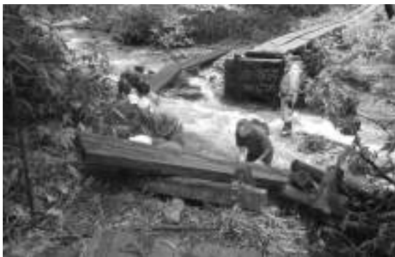
▲7月末の集中豪雨により流失した橋の復旧作業にあたる関係者
