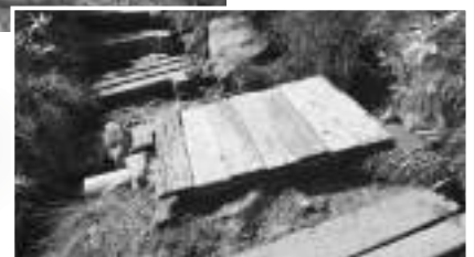
横断排水 左上:作業前 右下:作業後
