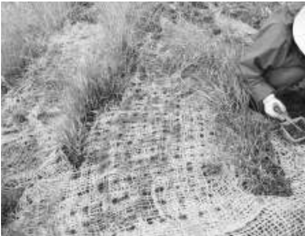
▲ 敷設されたネットと網目の中の泥団子
