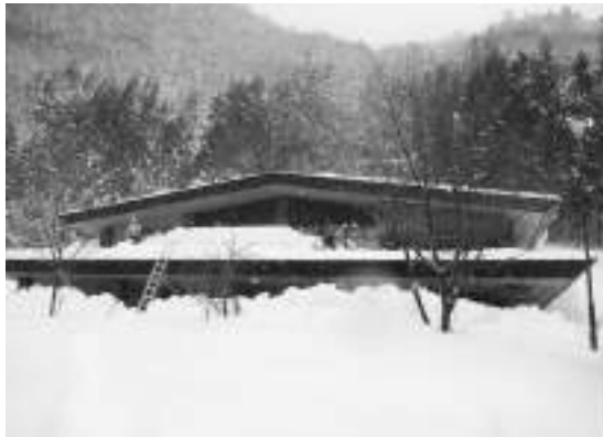
▲1月19日の作業の様子
