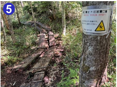
5 一部痛みの激しい木道があります。濡れていると大変滑りやすいので気を付けて歩きましょう。
