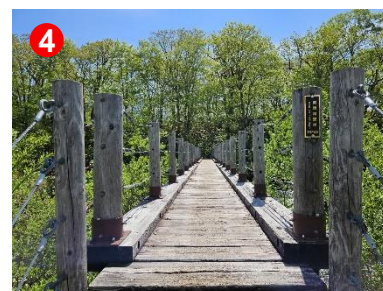
4 東電尾瀬橋の欄干が設置されました。
