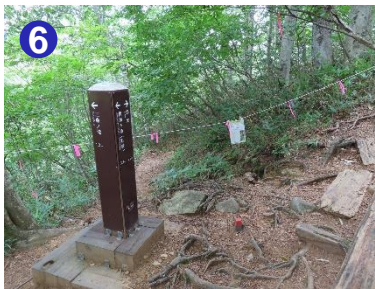
6 三條ノ滝は10月3日(予定)まで木道改修工事の為、通行禁止ロープが張られています。
