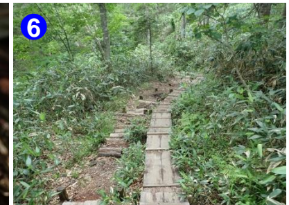
6 部分的に破損した木道があります。特に雨上がりなど濡れている時には十分注意してください。
