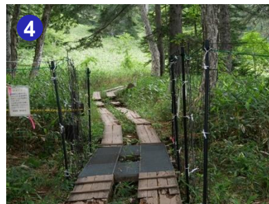
4 大江湿原入口にはシカ対策としてグレーチングが設けられています。注意して通行してください。
