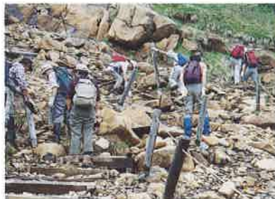
登山道沿いの柵立て作業
