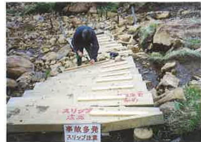
東面登山道の修繕作業
