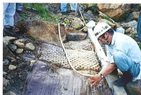
生分解性植生マットの据付
