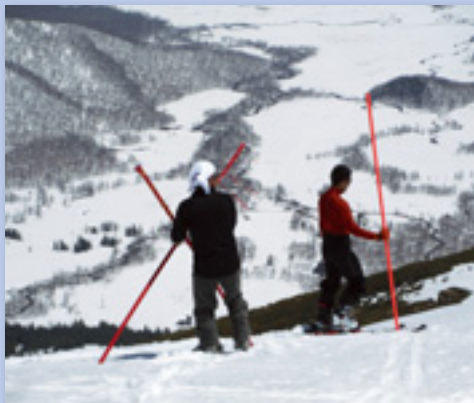
立入禁止区域を明確にする誘導ポール設置の様子
