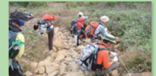
ボランティアと行う立入防止柵設置作業の様子
