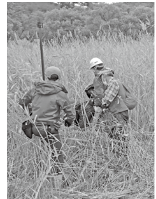
保護柵撤去作業
