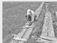
木道の栈木打ち作業
